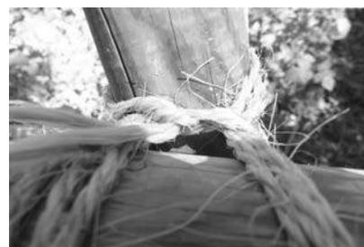
8/ Attacher la perche à l'horizontale avec un nœud de brelage. Faire plusieurs tours. Consolider avec des nœuds de serrage et fixer l'assemblage avec un nœud plat.
