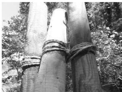
Tremper la Sisal dans une bassine d'eau permet de resserrer les nœuds et de fortifier l'installation.
